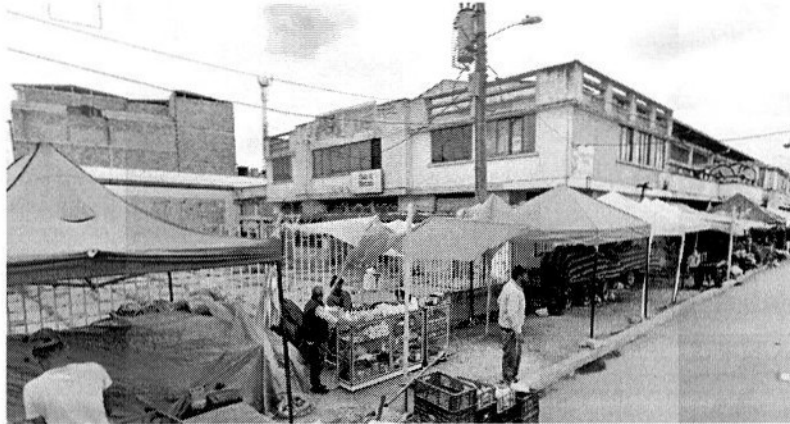
Ilustración 3. Estado estructura de la plaza de mercado del municipio de Soacha
